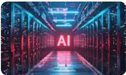
Data Center AI Servers
